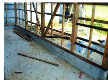
再利用できる柱と基礎は残し、壁を解体。
