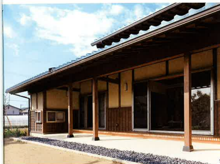
1.濡れ縁の下は、素朴で味わいがある土間たたき。通常はコンクリートで済ませる所にも、ご主人の要望がきちんと生かされた。
