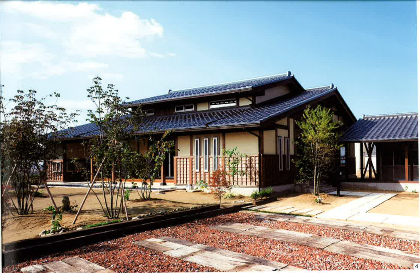
4.棟上の隠屋根が、いいアクセントになっている。西日が当たる面には、将来のメンテナンスを考え、サイディングを使用。
