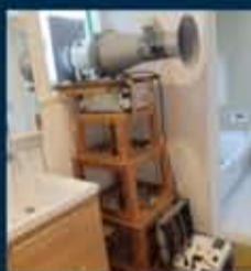
C値(住宅の隙間の大きさ)測定の様子
