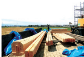
耐震強度の高い丸太の梁と5寸柱
