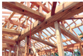
組み上がった構造体
